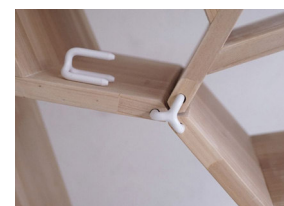
Possible detall tècnic per encaix de les peces.
