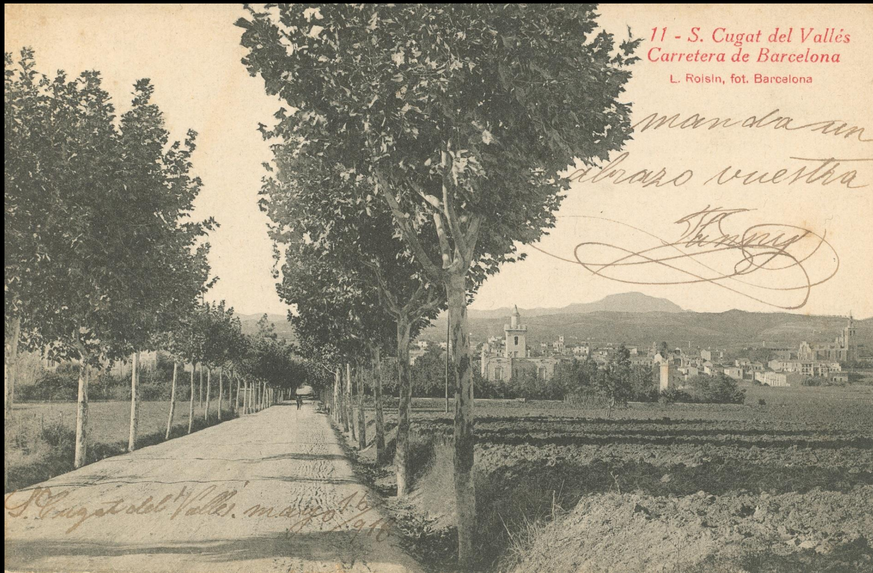
Entrada de la carretera de l'Arrabassada a Sant Cugat els Vallès. Primera dècada del segle XX (Col·lecció Ricard Mestre)
