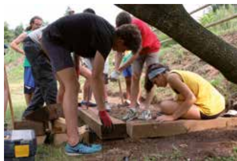
Treballs de construcció de parterre
