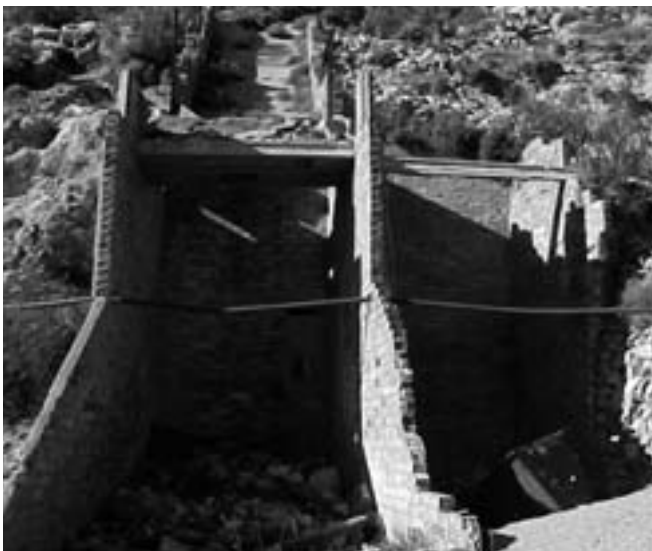
Restauració de les mines del Matagalls
