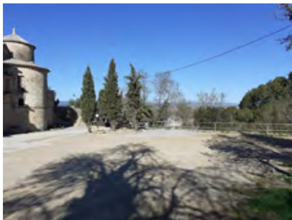
Aparcament del Castell de Penyafort. Font: Arxiu XPN
