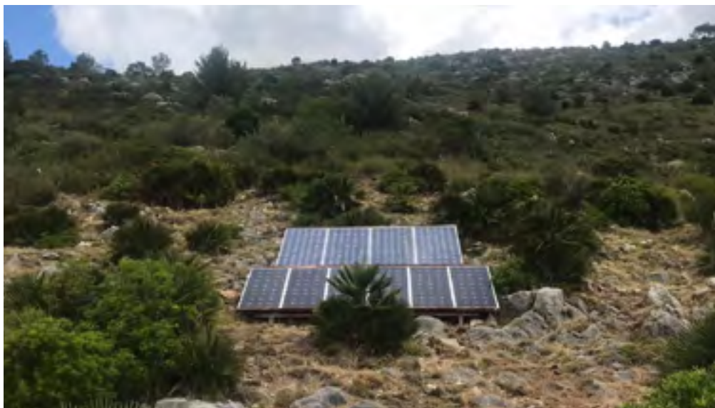
Sistema fotovoltaic a Vallgrassa. Font: Arxiu XPN
