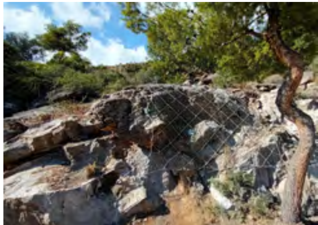
Detall de l'estabilització d'un talús. Font: Arxiu XPN
