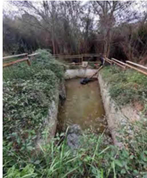
Instal·lació de la rampa a la bassa de Pregons. Font: Arxiu XPN
