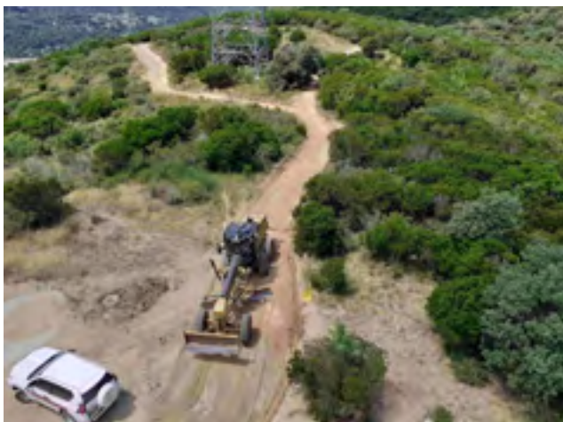
La motonivelladora treballant sota la torre Bravo, a la Coscollada. Font: Arxiu XPN
