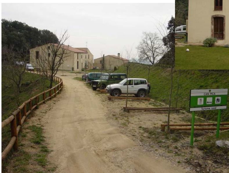
Vista general dels aparcaments, barana de protecció i enjardinament
