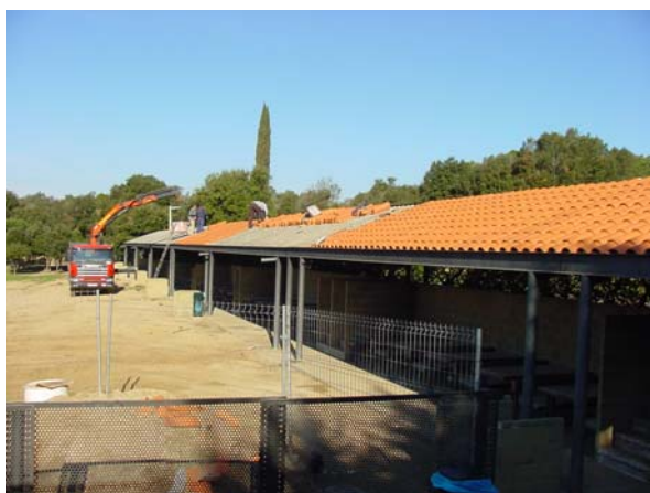
Millora de la teulada de la zona de taules
