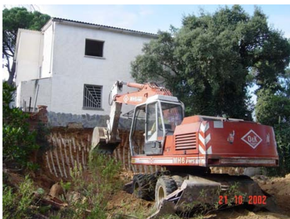
Operacions d'enderroc d'edificacions
