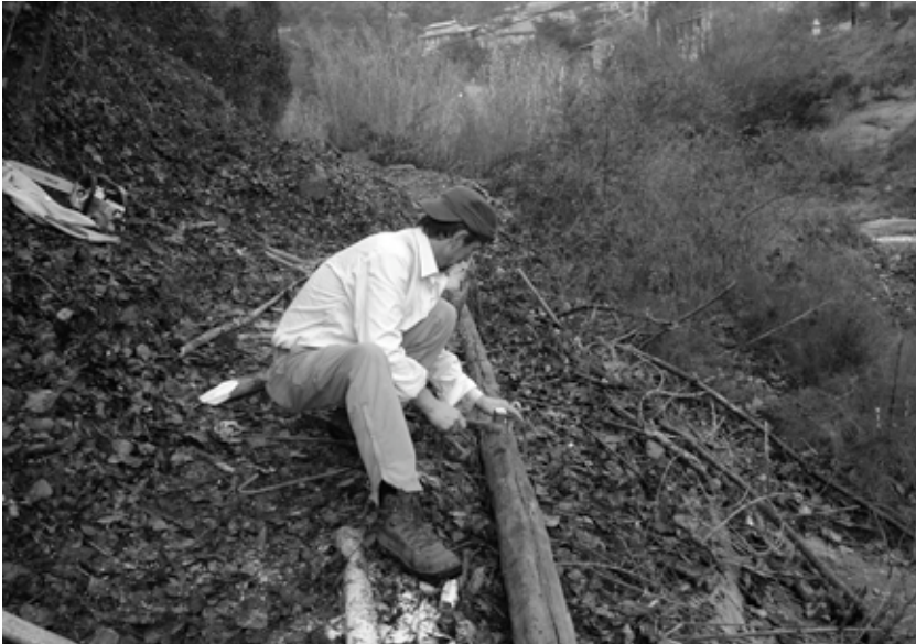
Arranjament de l'itinerari de les fonts de Mura
