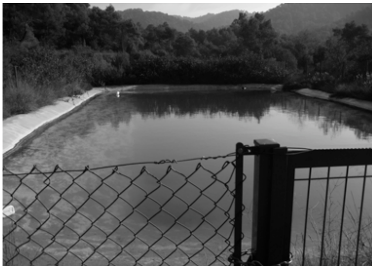
Bassa de les Vendranes
