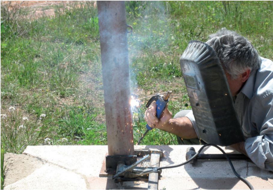
Arranjament de la barana de la Pastora
