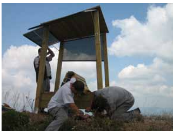
Instal·lació de la pèrgola de fusta al punt de guaita del Montcau
