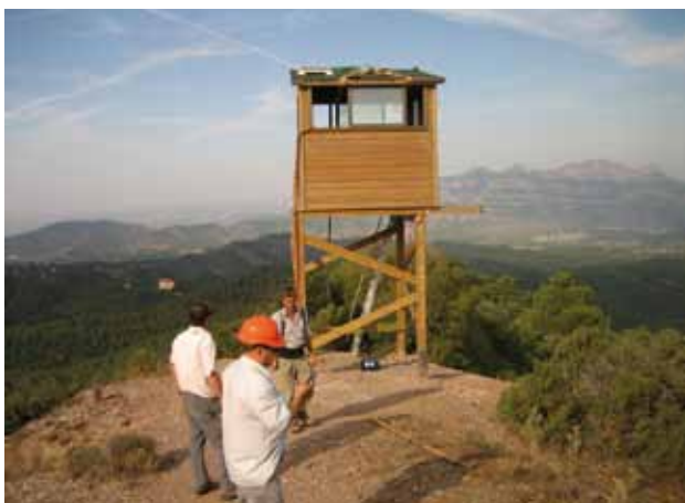
Instal·lació de la torre de guaita a l'Obac
