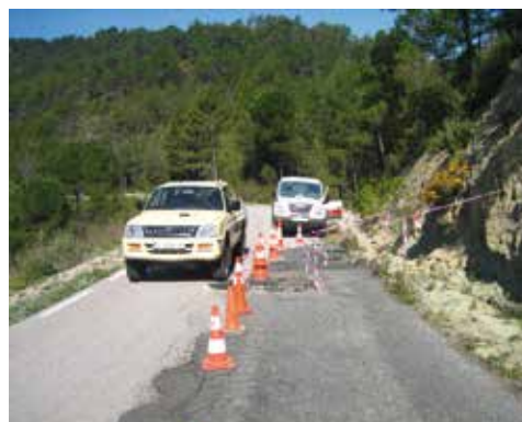
Arranjaments a la carretera de Lligabosses
