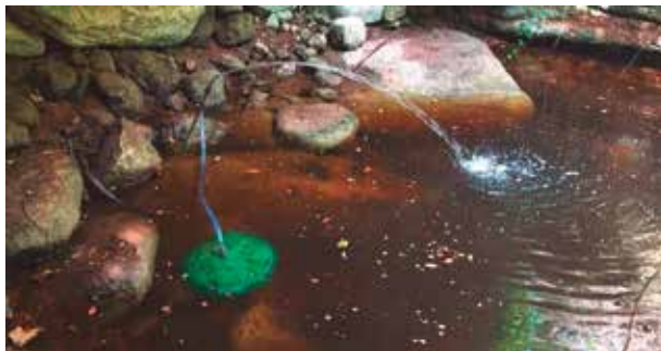
Instal·lació provisional d'una bomba de recirculació amb filtres per netejar i oxigenar l'aigua del gorg
