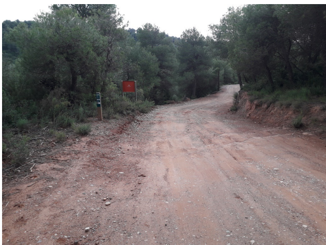
Tram del camí de Casajoana abans de l'arranjament
