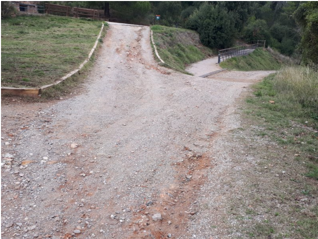
Accés al restaurant de La Pastora abans de les obres de millora. Font: XPN
