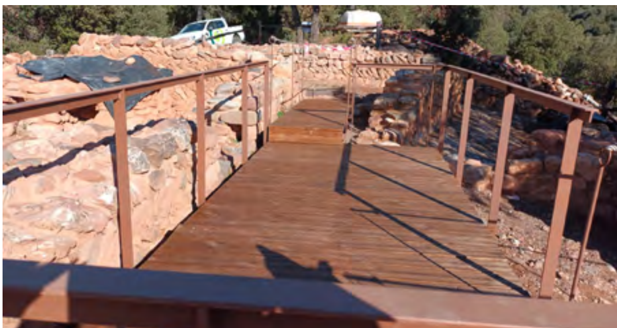
Instal·lació de la passarel·la a les restes arqueològiques de Serra Llarga. Font: Arxiu XPN
