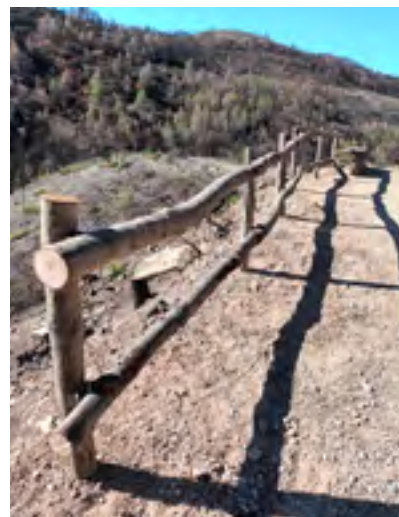
Substitució de les baranes del mirador de les Tines. Font: Arxiu XPN
