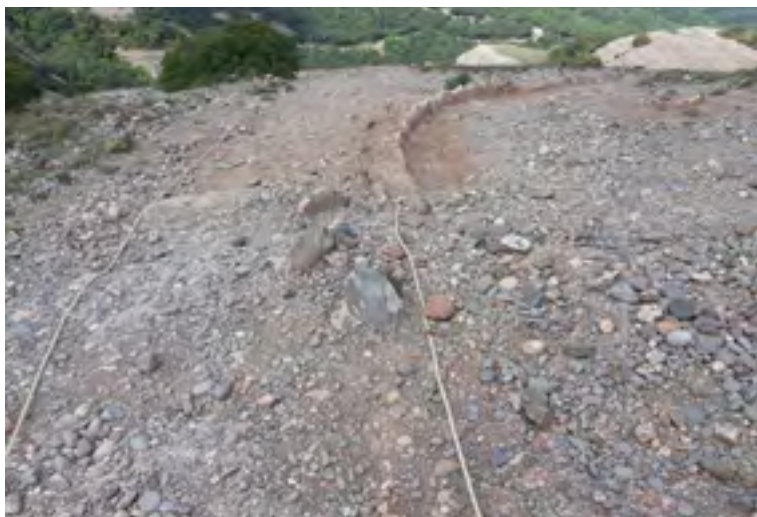
Substitució de les cordes dels camins d'accés al Montcau. Font: Arxiu XPN
