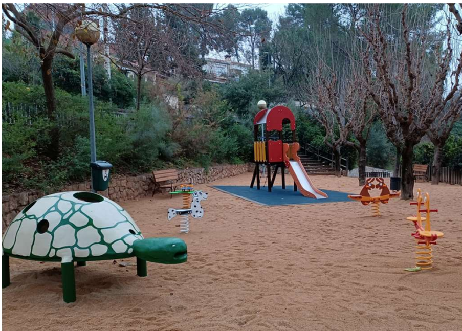
Font Ajuntament d'Abrera. Treballs de millora al parc de la tortuga (Les Carpes)
