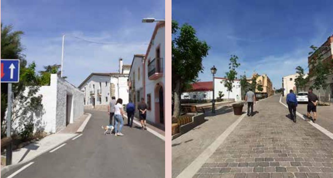
En esta travesía sin aceras accesibles, con dificultades de acceso a las viviendas y sin la posibilidad de desviar ni siquiera un sentido de circulación, se ejecutó una prueba piloto de tráfico alternativo con señalización. Actualmente, ya se ha ejecutado la transformación definitiva de la travesía, donde se ha reducido la velocidad de 40 km/h a 20 km/h y se ha creado una plataforma única en el tramo central de prioridad de peatones.
