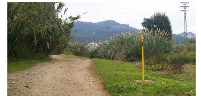
Fita convencional d'un servei soterrat que informa sobre la seva
