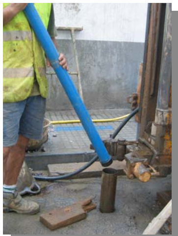
Fotografia 2.1. Tub piezomètric de PVC.
